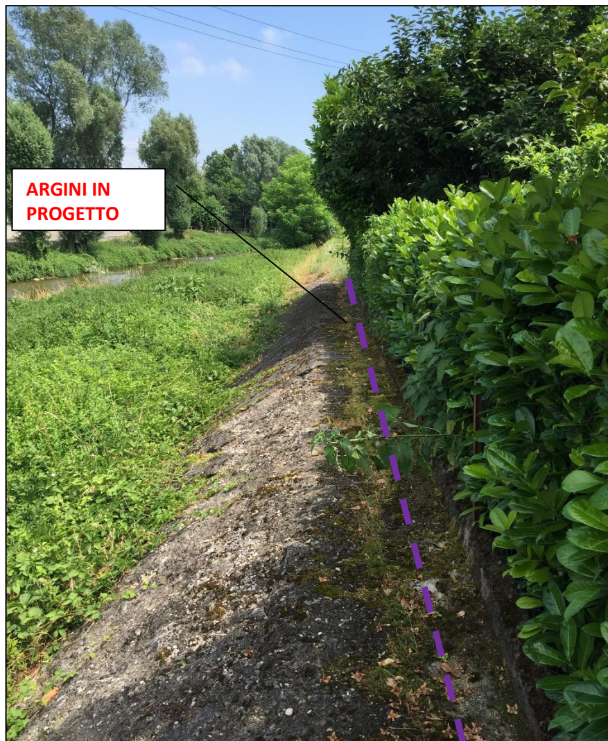
Figura 19. Area d'intervento: muro arginale in c.a. (sponda destra)
